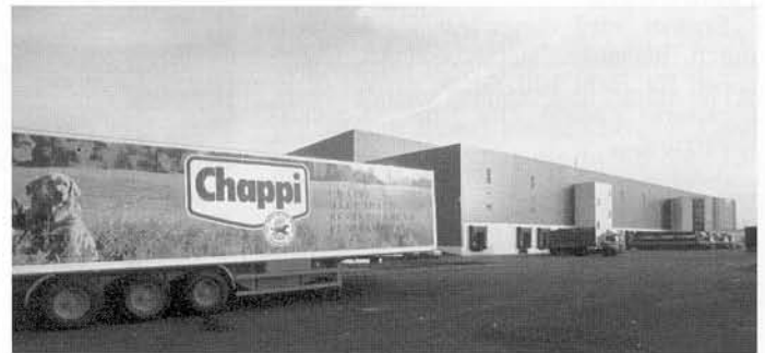
1: Außenansicht des Logistikzentrums. Links hinter dem Lkw das Hochregallager und davor die Kommissionier- und Versandhalle
