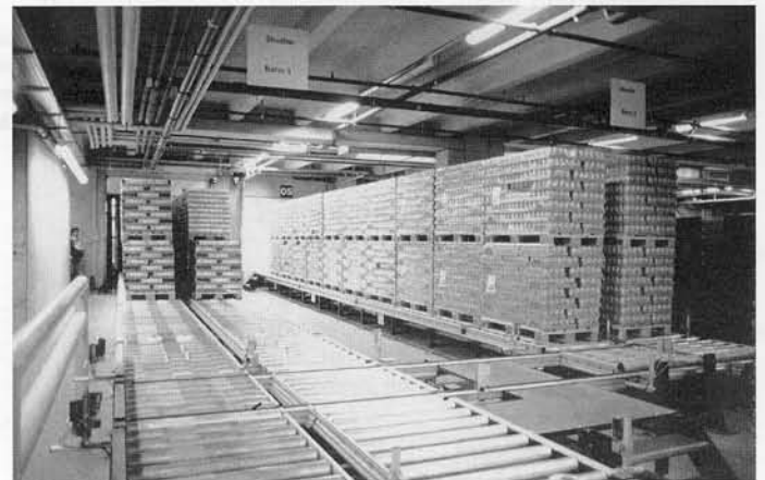
3: Über die Shuttle-Bahnen gelangen die Paletten vom Lkw in den Wareneingang (links). Die Bahn (rechts im Bild) übernimmt die Beladung der Lkw
