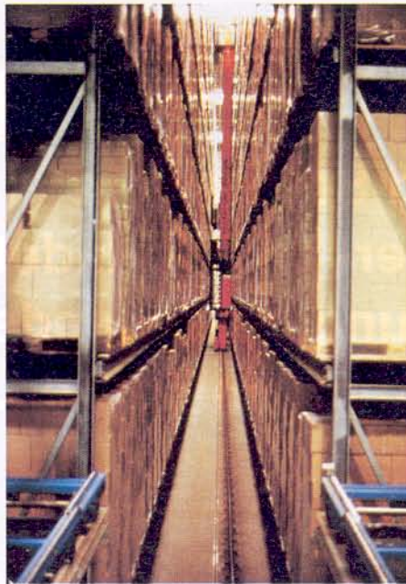
3: Eine der vier HRL-Gassen in dem komplette Palettenladungen und Anbruchpaletten gelagert werden
